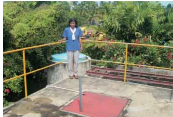
自身が設計し完成した排水処理設備
