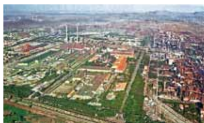
Vijayanagar Works 全景
