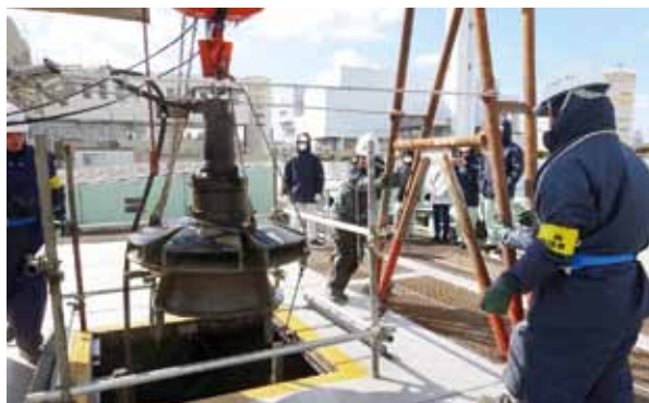
作業中の安全対策を見学 保守点検のために吊り上げられた水中攪拌機
