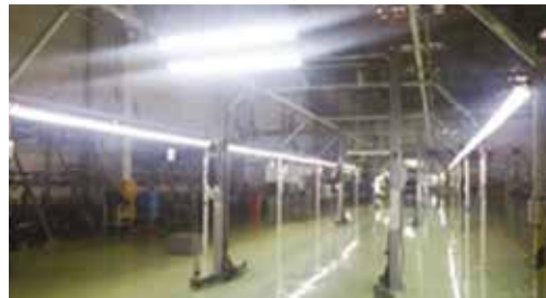
改善例: 70個の112Vの蛍光灯を72VのLEDに交換
