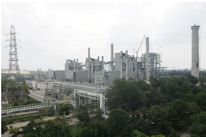
マプタプットエコ工業団地の 第二次・火力発電所増設の状況
