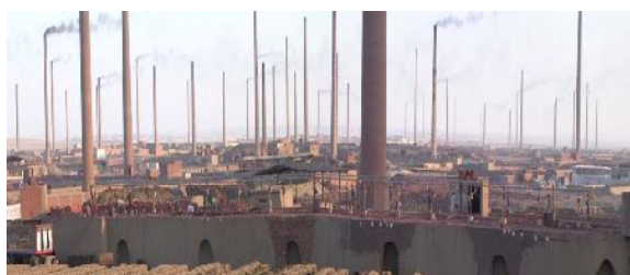
工場団地煙突群
