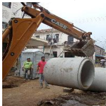
新設排水パイプラインの工事
