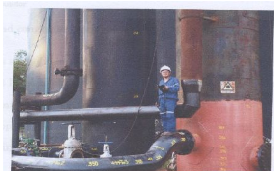
機器配管の非破壊検査実施中の帰国研修員
