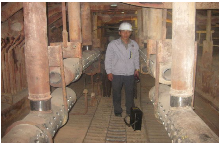
左写真： ボイラー室検査中の研修員
