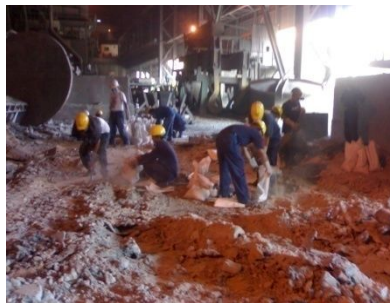
【写真左 (2枚)】廃棄耐火物の回収作業・分別作業
