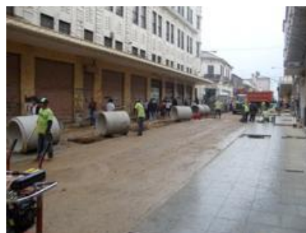
新設排水パイプラインの工事
