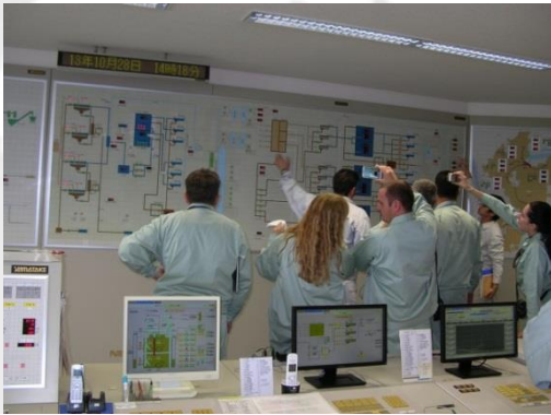
皇后崎浄化センター中央操作室見学
