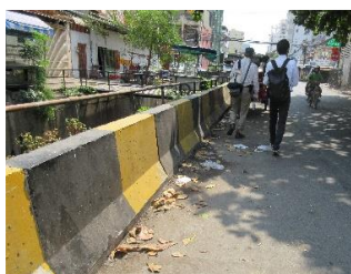
①水路沿いにコンクリート壁を新たに設置
