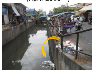
道路から水路へごみが落ちる (February 2018予備調査時確認)
