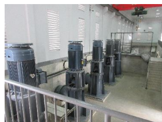
⑫水路の揚水ポンプの増強 (5台から10台へ)
