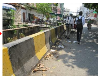
コンクリート壁を新たに設置 道路から水路にごみは落ちない (January 2019確認)
