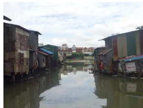
ポンプ場側に流れ着く浮遊ごみは激減(2022年5月)
