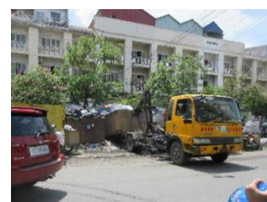
CPのコンテナ交換作業
