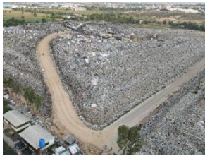
処分場内パッカー車進入路の整備
