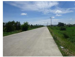
処分場アクセス道路を整備
