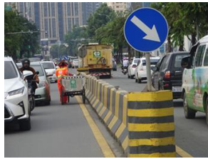
手作業で道路清掃
