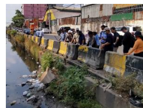
水路の不具合対策を協議
