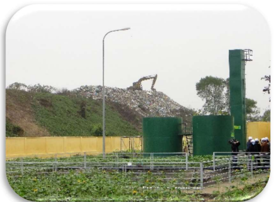
写真 1-4 埋め立て処分場浸出水 処理施設
